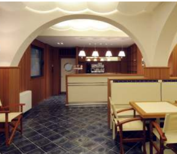
Platten aus Basalt in den Abmessungen 200x200 oder 250x250 mm, hergestellt durch Schmelzen bei 1300°C
