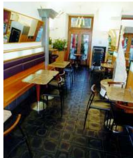
Platten aus Basalt in den Abmessungen 200x200 oder 250x250 mm, hergestellt durch Schmelzen bei 1300°C
