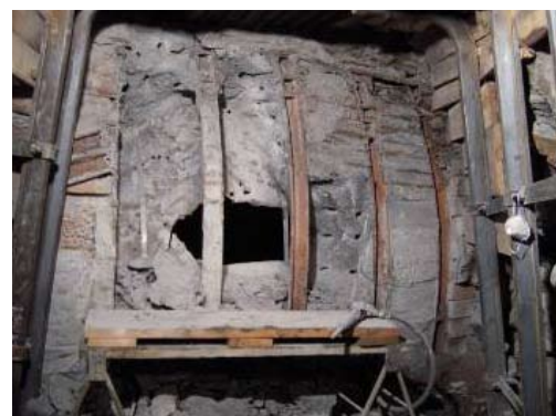
Abb. 9 Durchbruch in den Abwasserkanal „K“
