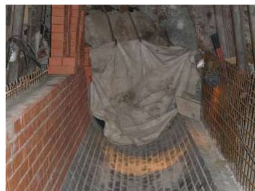
Abb. 10 Ausbau des Anschlusses an den Abwasserkanal „K“
