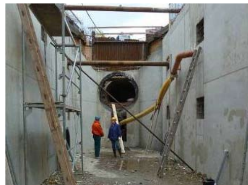
Abb. 8 Betonierung der Wände
