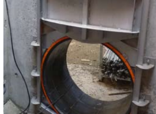
Abb. 6 Ring aus kalibrierten Radialformstücken aus Schmelzbasalt
